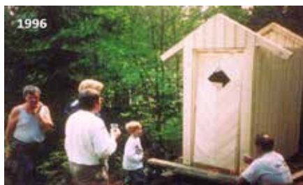
Huussin pystytys näköalapaikalle.
